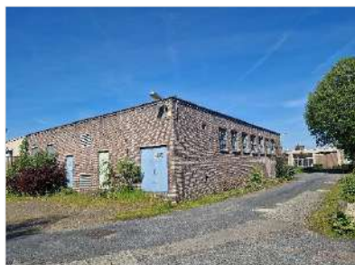
Figuur 2.4 Zuidoostzijde van het hoofdgebouw.
