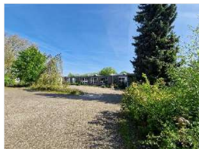
Figuur 2.5 Zuidwestzijde hoofdgebouw met parkeergelegenheden en opgaande begroeiing.
