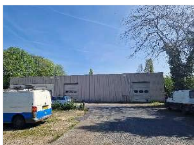
Figuur 2.6 Opslagloods aan oostzijde van de onderzoekslocatie.
