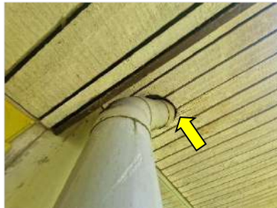
Figuur 5.2 Spleten tussen de planken en rondom regenpijpen waar vleermuizen gebruik van kunnen maken.
