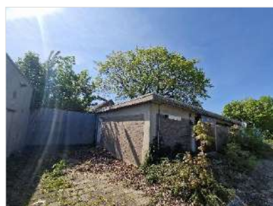
Figuur 2.8 Opslaggebouw voor chemicaliën aan zuidzijde van de onderzoekslocatie.
