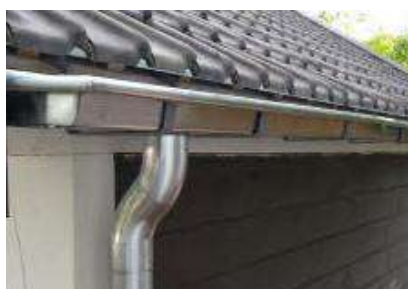
afbeelding 6.09: goten/afvoer in zink
