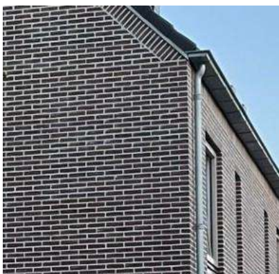
afbeelding 6.07: kantpan met rollaag
