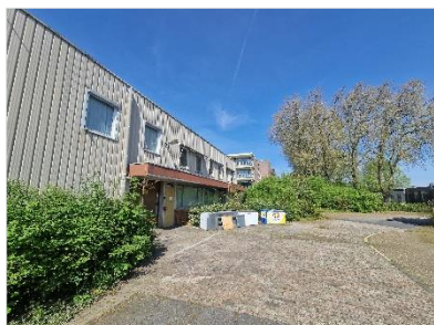
Figuur 2.9 Opslagloods aan westzijde van de onderzoekslocatie.
