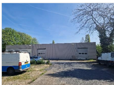
Figuur 2.6 Opslagloods aan oostzijde van de onderzoekslocatie.
