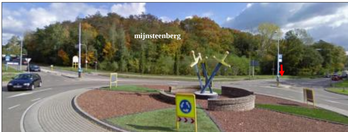
Figuur 17: : Zicht op het noordwestelijke deel van het plangebied (deelgebied Noord) vanaf de kruising Ganzepool (links) en de Rimburcherweg (rechts) in noordoostelijke richting met centraal de mijnsteenbergr die hier het vroegere dal van Rode Beek heeft afgedekt. De rode pijl markeert globaal de positie van boring 39.
