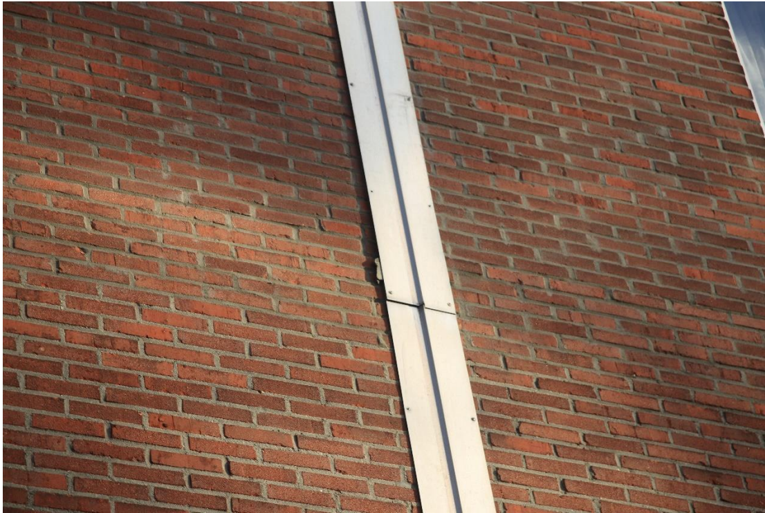
Foto 3: Openingen ter plekke van dilatatievoegen bieden ruimte voor vleermuizen om te dienen als vaste rust- en verblijfplaatsen
