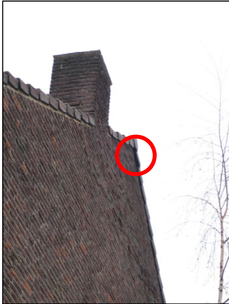
Locaties waar vleermuizen mogelijk toegang verkrijgen tot de spouw of onder de dakpannen (SAB, 2014).
