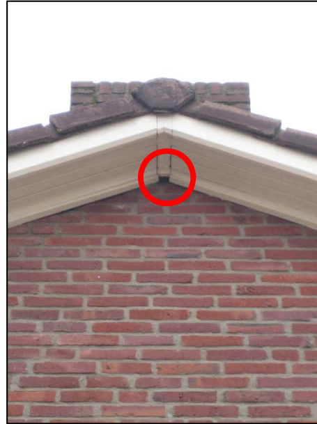
Locaties waar vleermuizen mogelijk toegang verkrijgen tot de spouw of onder de dakpannen (SAB, 2014).
