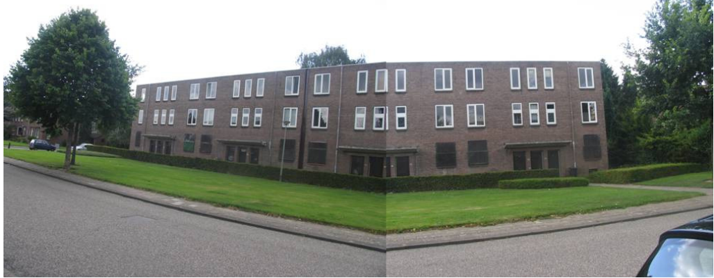
Figuur 7: Compositiefoto van de huidige situatie ter plaatse van de portiekflats die gesloopt gaan worden ten behoeve van de ontwikkeling van een brede school (Foto's: SAB 2009)
