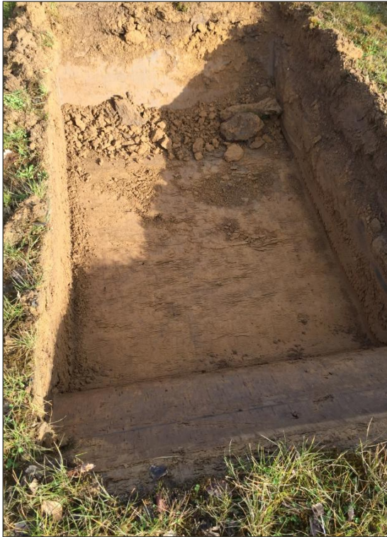
Afbeelding 5: Infiltratieput wadi C Raadhuisstraat
