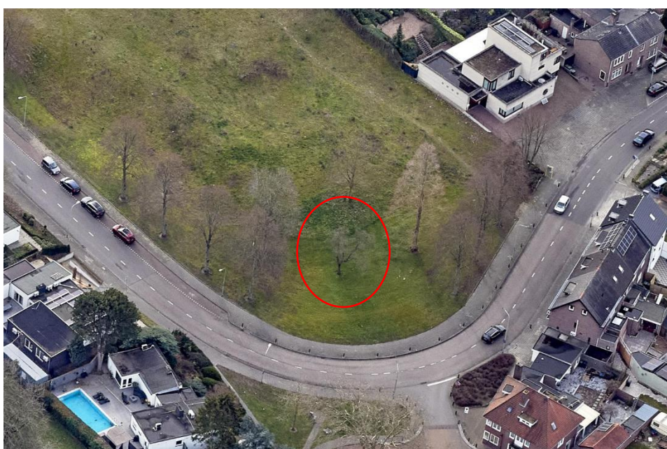
Figuur 4: de oude esdoorn op het noordelijke gedeelte van de onderzoekslocatie met gaten. Op de foto is noord beneden.
