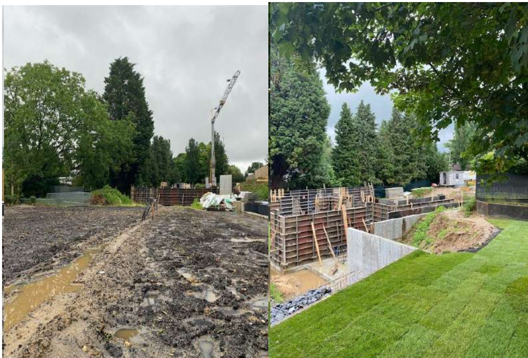
Figuur 1.2: foto's van de grond- en bouwwerkzaamheden
