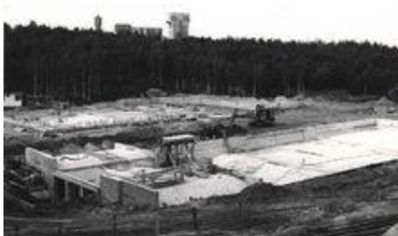
Aanleg zwembad 1961 met Staatsmijn Hendrik op de achtergrond
