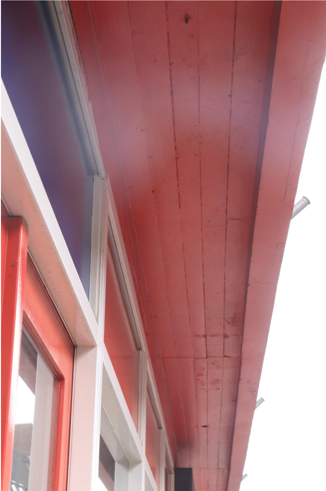
Foto 3: De constructie biedt nergens invliegopeningen voor vleermuizen.
