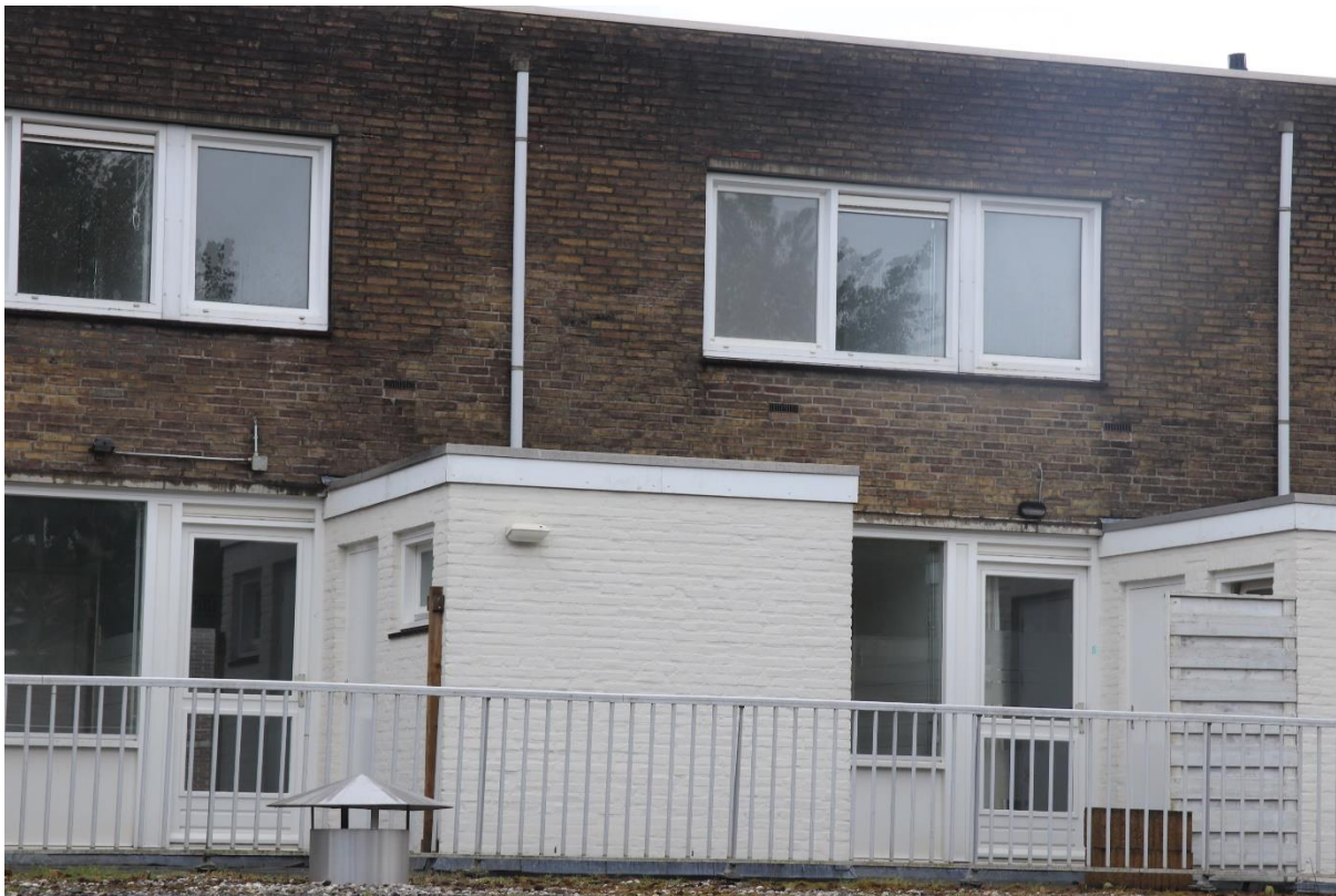
Foto 4: Ook aan de achterzijde van het onderzochte pand zijn nergens open stootvoegen aanwezig die door vleermuizen gebruikt zouden kunnen worden
