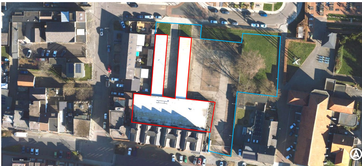
Figuur 1 Ligging plangebied (bij benadering blauw omkaderd) en de te slopen bebouwing (bij benadering rood omkaderd). Bron: Cyclomedia, 2023.
