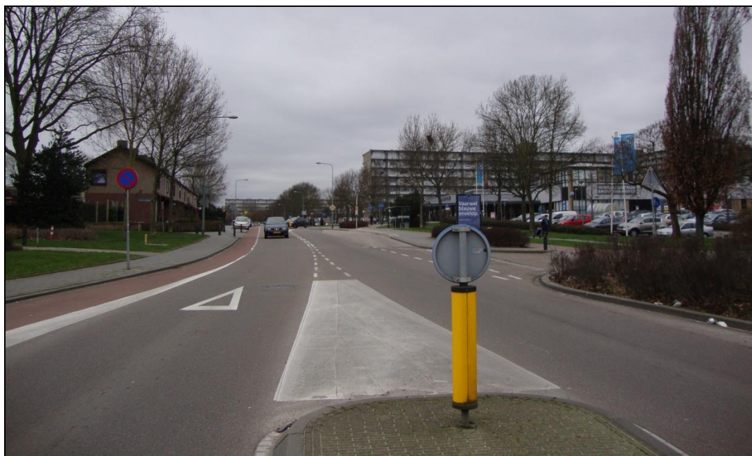
De Kennedylaan in zuidwestelijke richting
