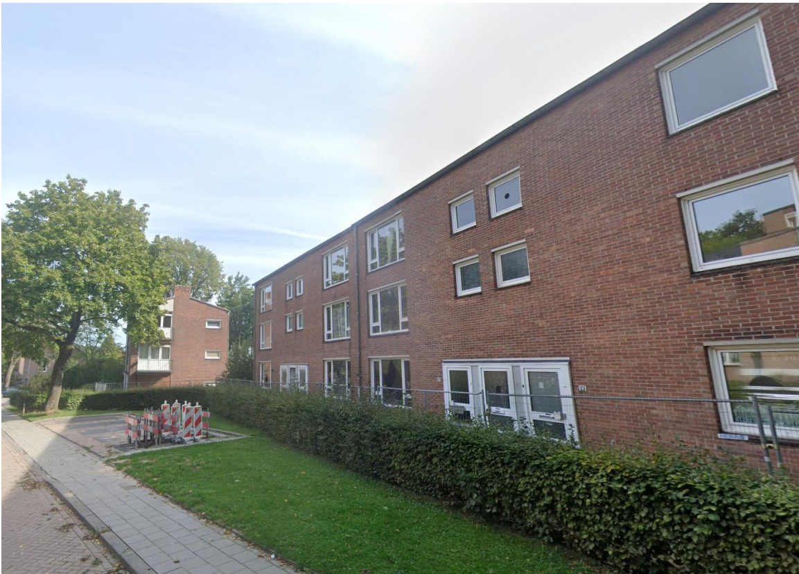
Figuur 5: Aanzicht voormalige bebouwing Chopinstraat (bron: Google Earth)
